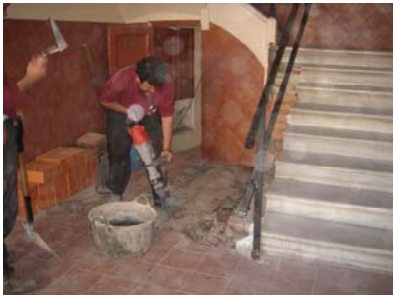
004 Desmuntatge UE 101 .JPG
