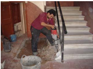
007 Desmuntatge UE 103.JPG
