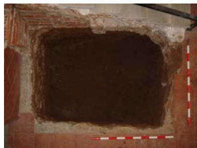
011 UE 105 Final de la intervenció.JPG
